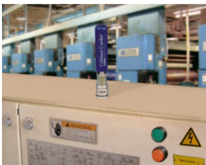
Condizionatore Exair 4040 su quadro elettrico di un impianto
