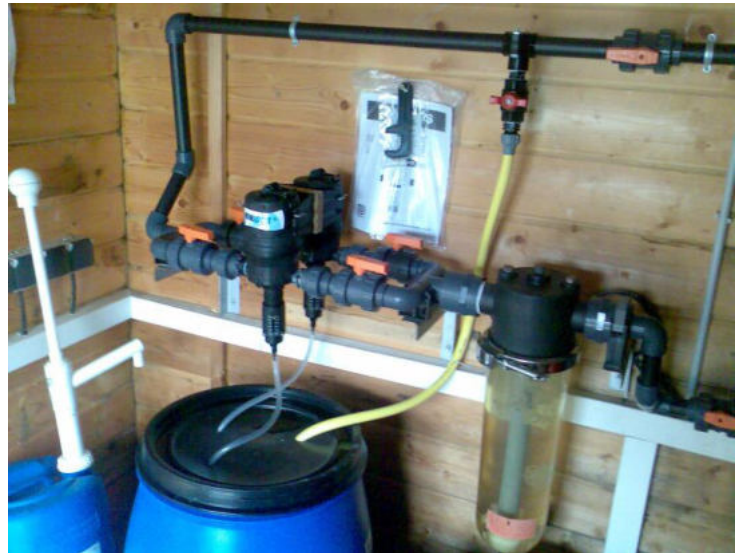
Impianto di miscelazione fertilizzanti
