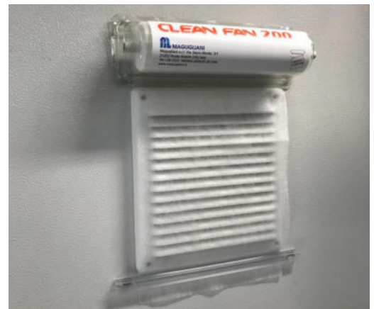
CLEAN FAN installato su ventola di un armadio elettrico
