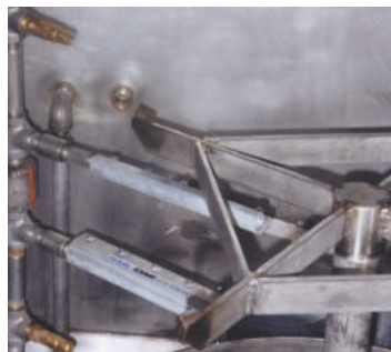
Asciugatura pezzi all'interno di una lavatrice industriale
