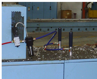
Condizionatori Exair 4030 su quadro elettrico di un'alesatrice
