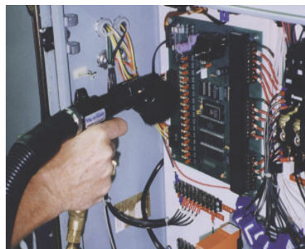
Vac-U-Gun con spazzola per aspirare polvere
