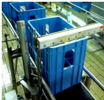
Asciugatura cassette di plastica per acqua minerale
