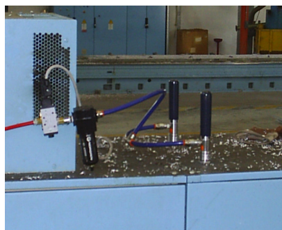
Condizionatori Exair 4030 su quadro elettrico di un'alesatrice
