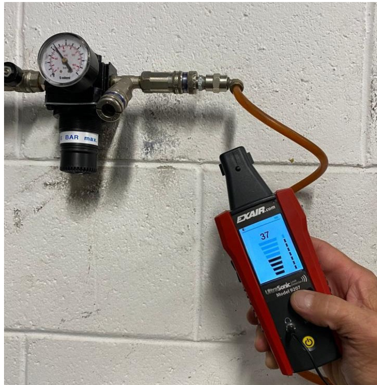
Verifica perdite da raccordi pneumatici
