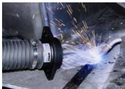
Aspirazione di fumi e gas prodotti durante la saldatura di pezzi
