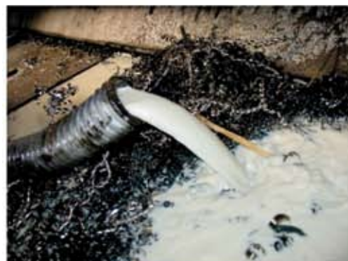
Emulsione in uscita dal depuratore - disoleatore MIXI
